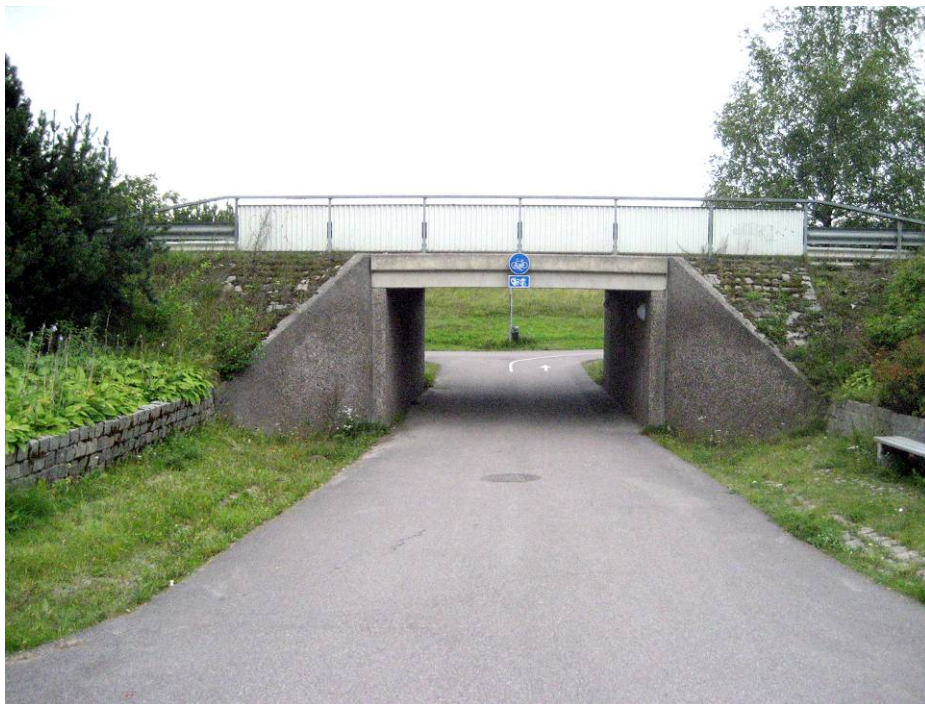
Bild 7 Gång- och cykeltunnel under Silvermyntsvägen
